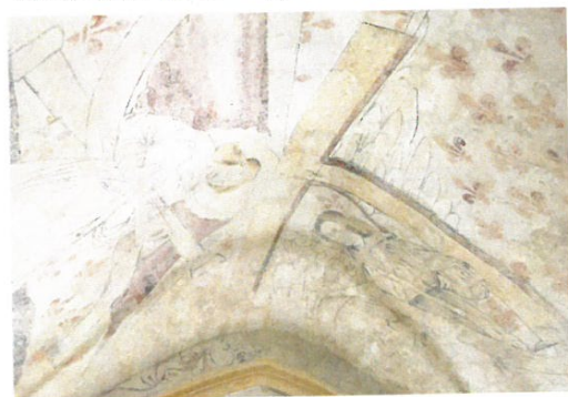
Voûtes de la chapelle de Brésillas après restauration : à gauche, ange portant la colonne de la Flagellation ; à droite, ange portant la Croix.
