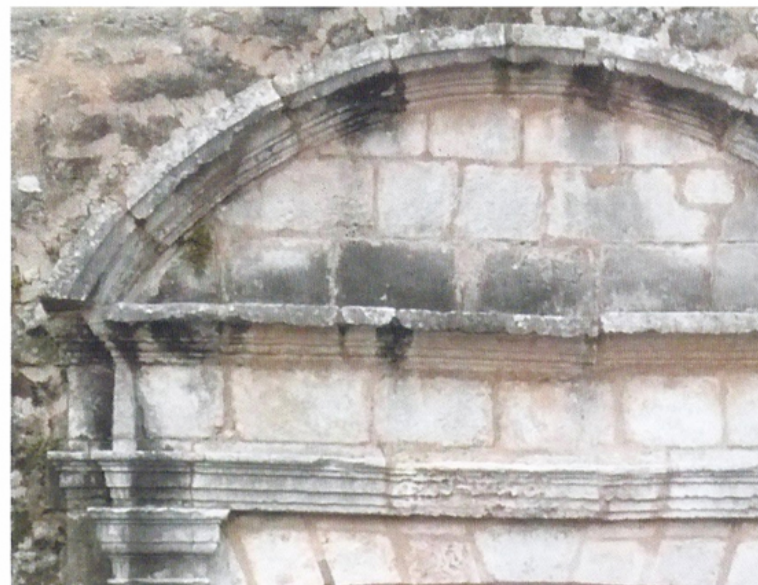
↗ 185. Développement de voiles d'algues sous les éléments saillants et dans les angles rentrants (zones non lessivées par les eaux pluviales) (Cliché : Elsa Ricaud, 2008)
