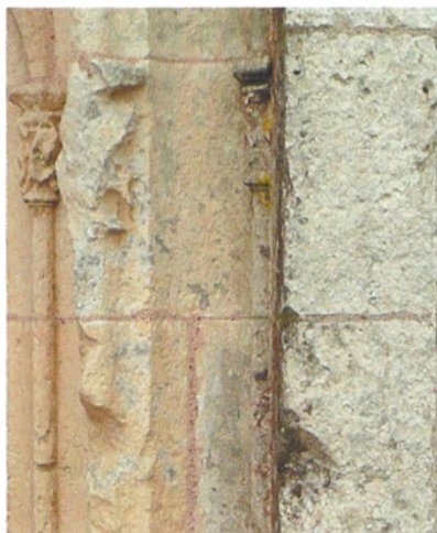
↓ 177. Pierre bûchée et érosion naturelle due aux vents marins d'ouest (Cliché : Elsa Ricaud, 2008)
